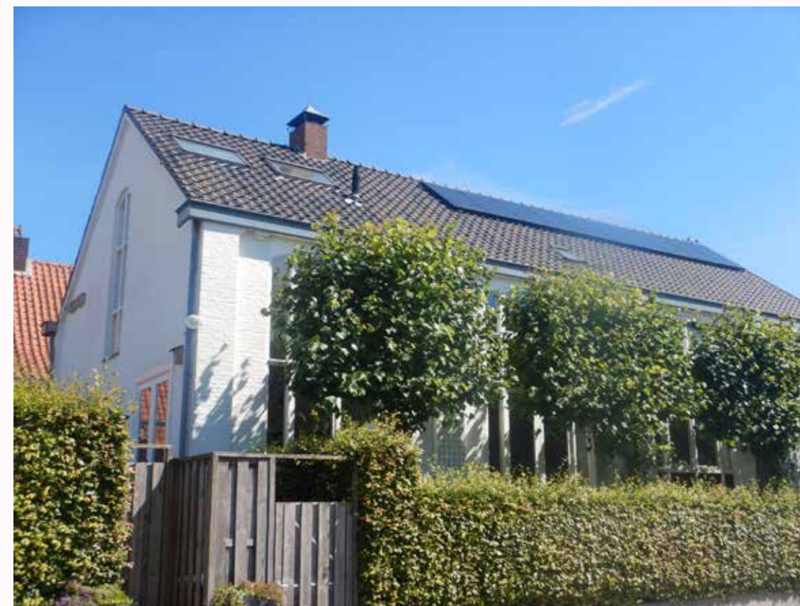
Zonnepanelen op de voormalige Gereformeerde Kerk in Wemeldinge
