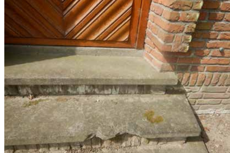
Afgebroken traptreden
