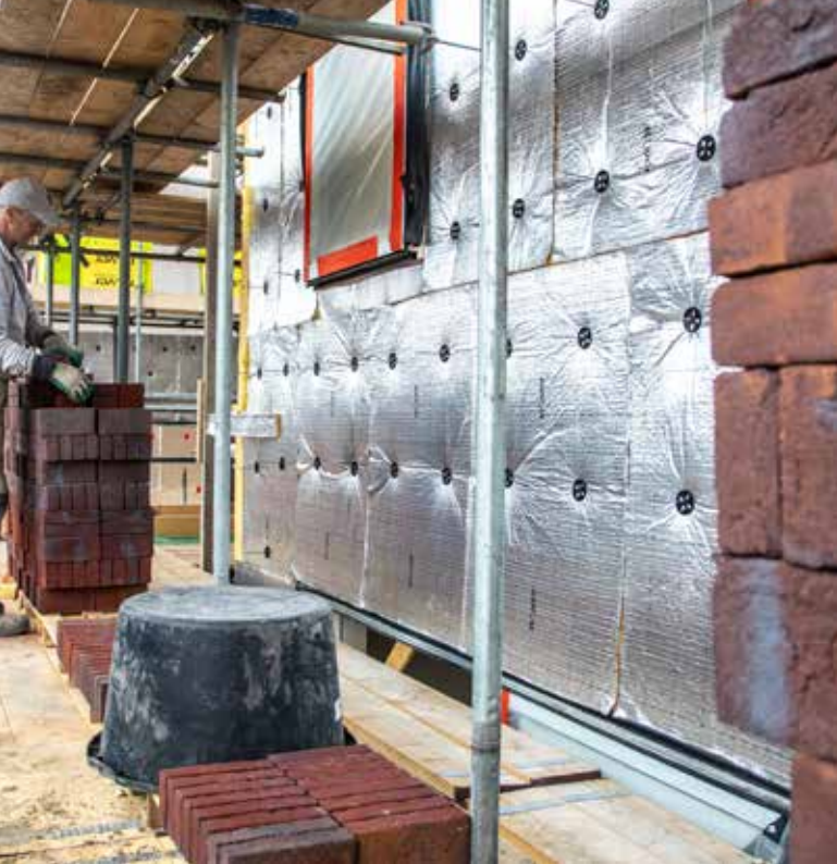
Figuur 12 Woning in aanbouw
