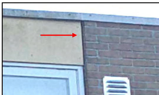
Afbeelding 3: Spleet langs kozijnen en beplating
