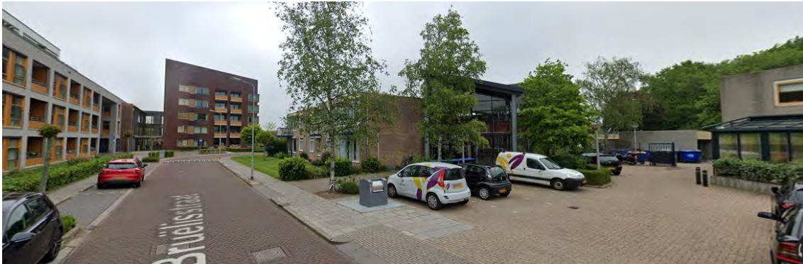
Figuur 2.1.4 Diverse woongebouwen aan de Bruëlisstraat (bron: Google Streetview, mei 2019)
