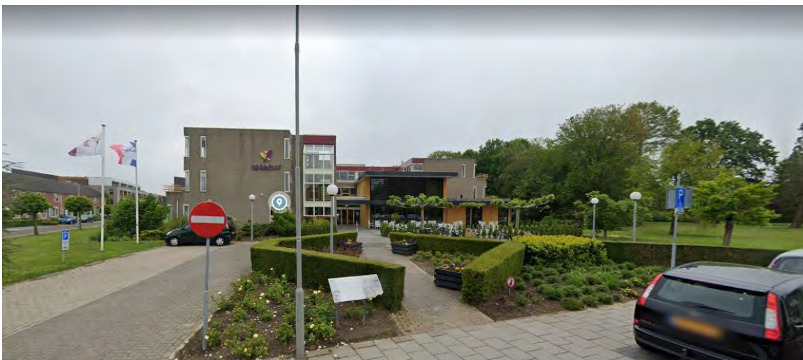
Figuur 2.1.3. De entree van het hoofdgebouw vanaf de Cederlaan (bron: Google Streetview, mei 2019)
