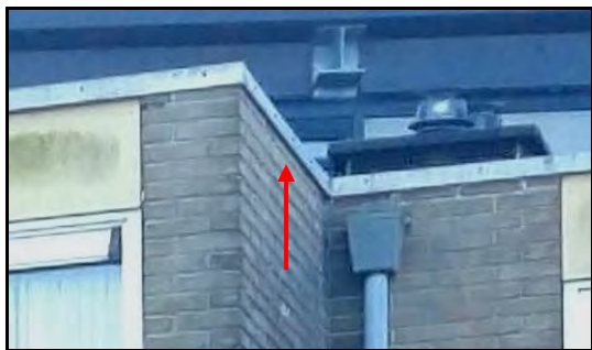
Afbeelding 5: Ruimte achter daklijst
