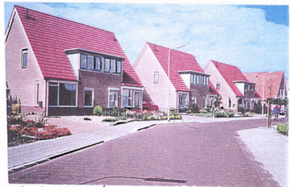
buitenrand kap met pannen
